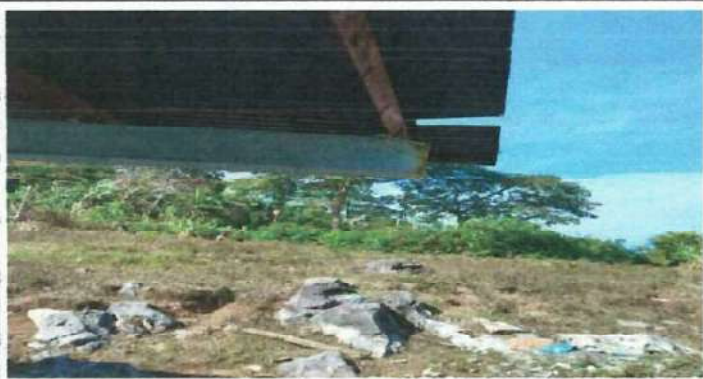
Foto 3: Colocacion de canales galvanizadas con su cargador de metal.
