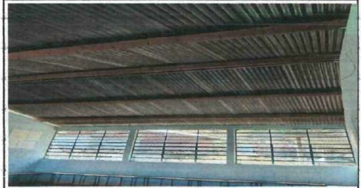
Foto 4: Mantenimiento de estructuras metalicas.
