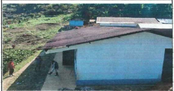
Foto 2: Sustitucion de lamina de techo.
