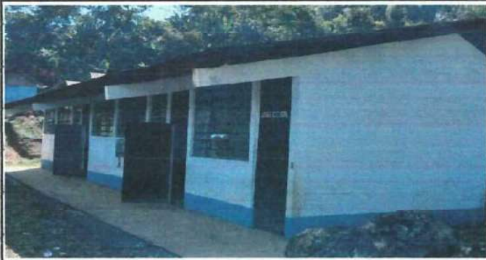
Foto 1: Sustitucion de puertas en mal estado del establecimiento.
